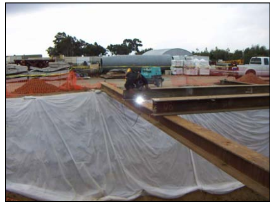
(d) Welding steel beams
