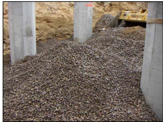
(d) Backfilling bottom of the pit with gravel
