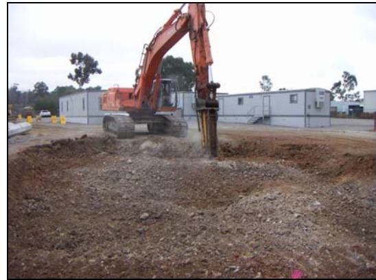
(d) Breaker to remove rigid layer
