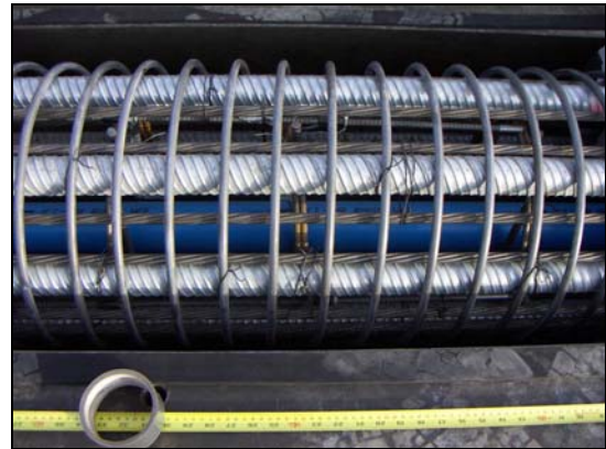
(d) After placement of spiral
